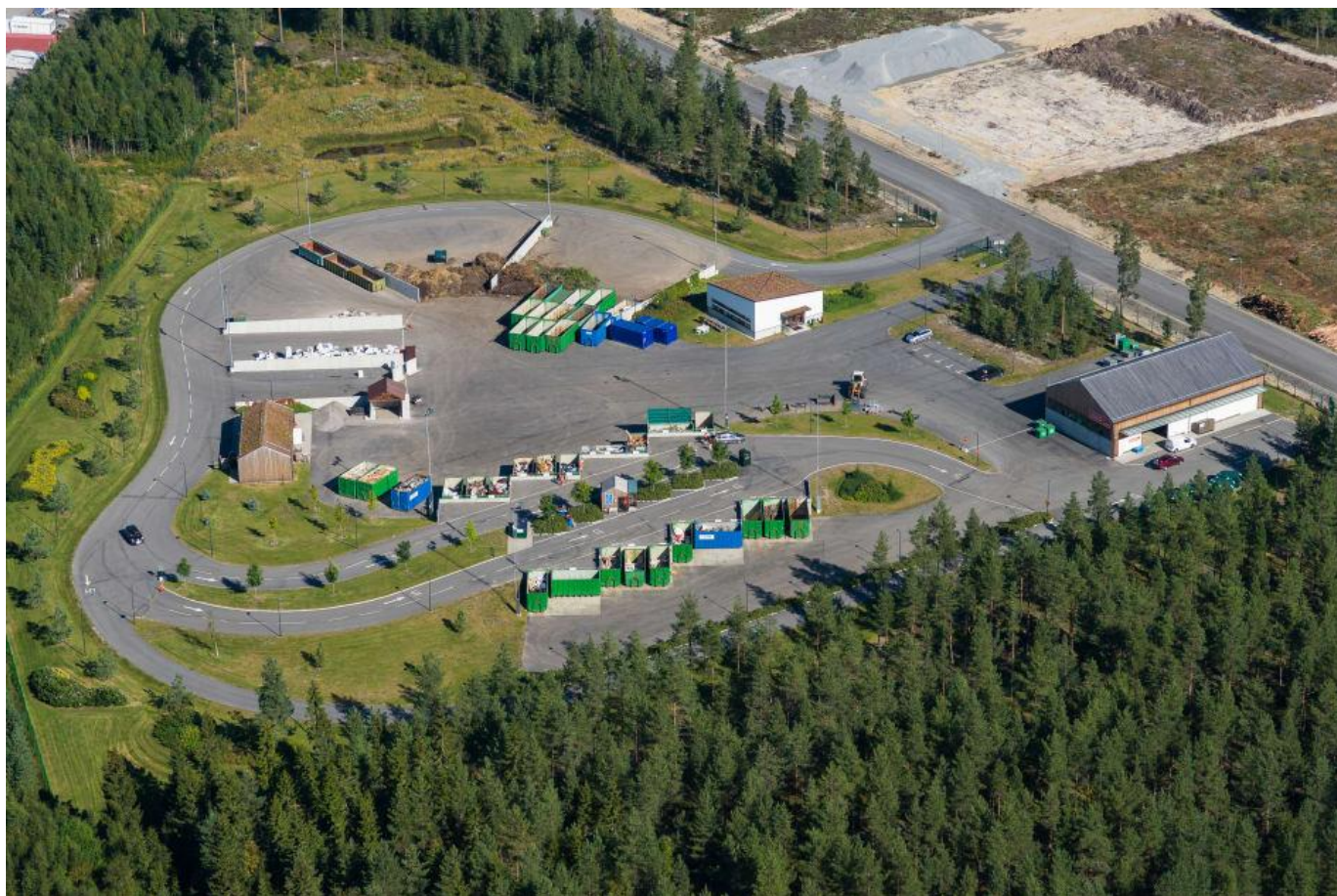
коммунальная станция по разделному сбору отходов
