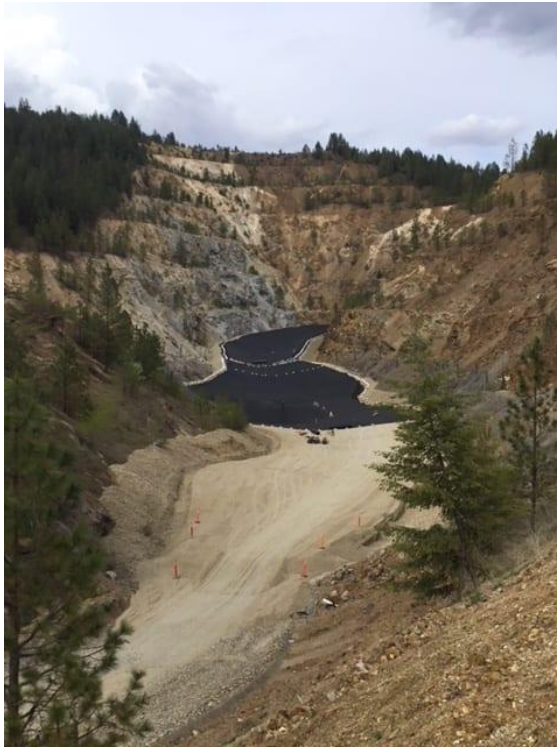
обустройство площадки для захоронения отходов
