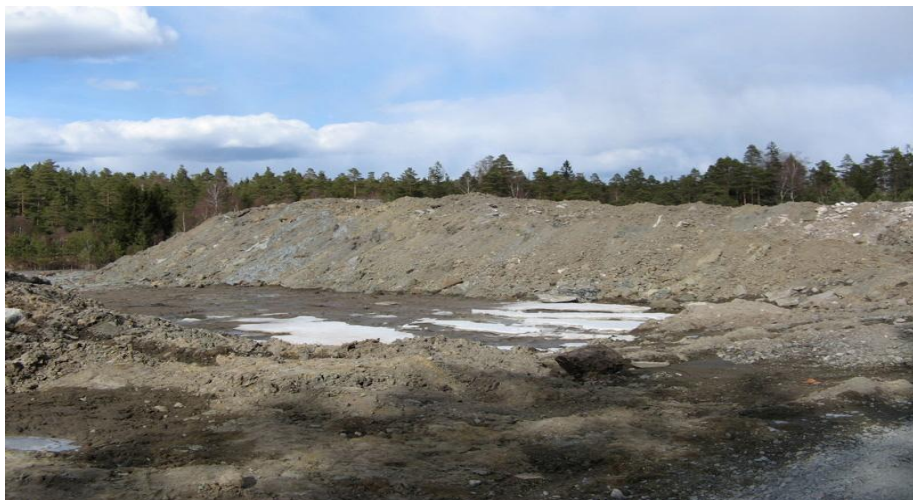
фрагмент дренажной системы
